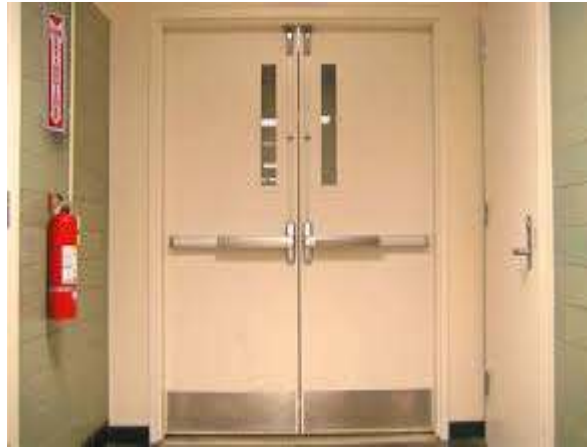
Resim 4. Acil Yangın Çıkış Kapısı [4]
